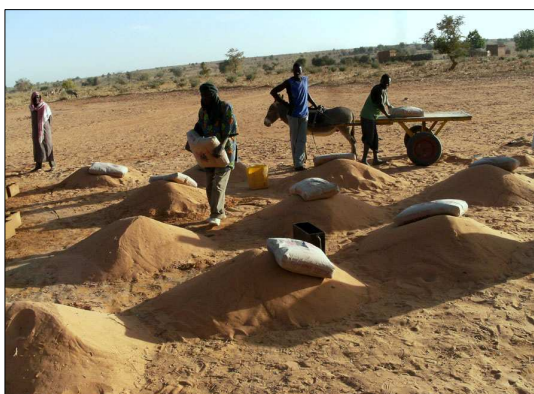
Préparation du mélange sable - ciment
