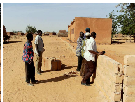
Le mur se construit à l'arrière de la cour
