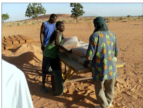
Les sacs de ciment arrivent sur le chantier
